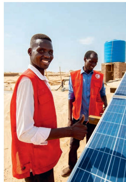
Volontärer från vår partnerförening i Sudan vid nyinstallerade solpaneler.
